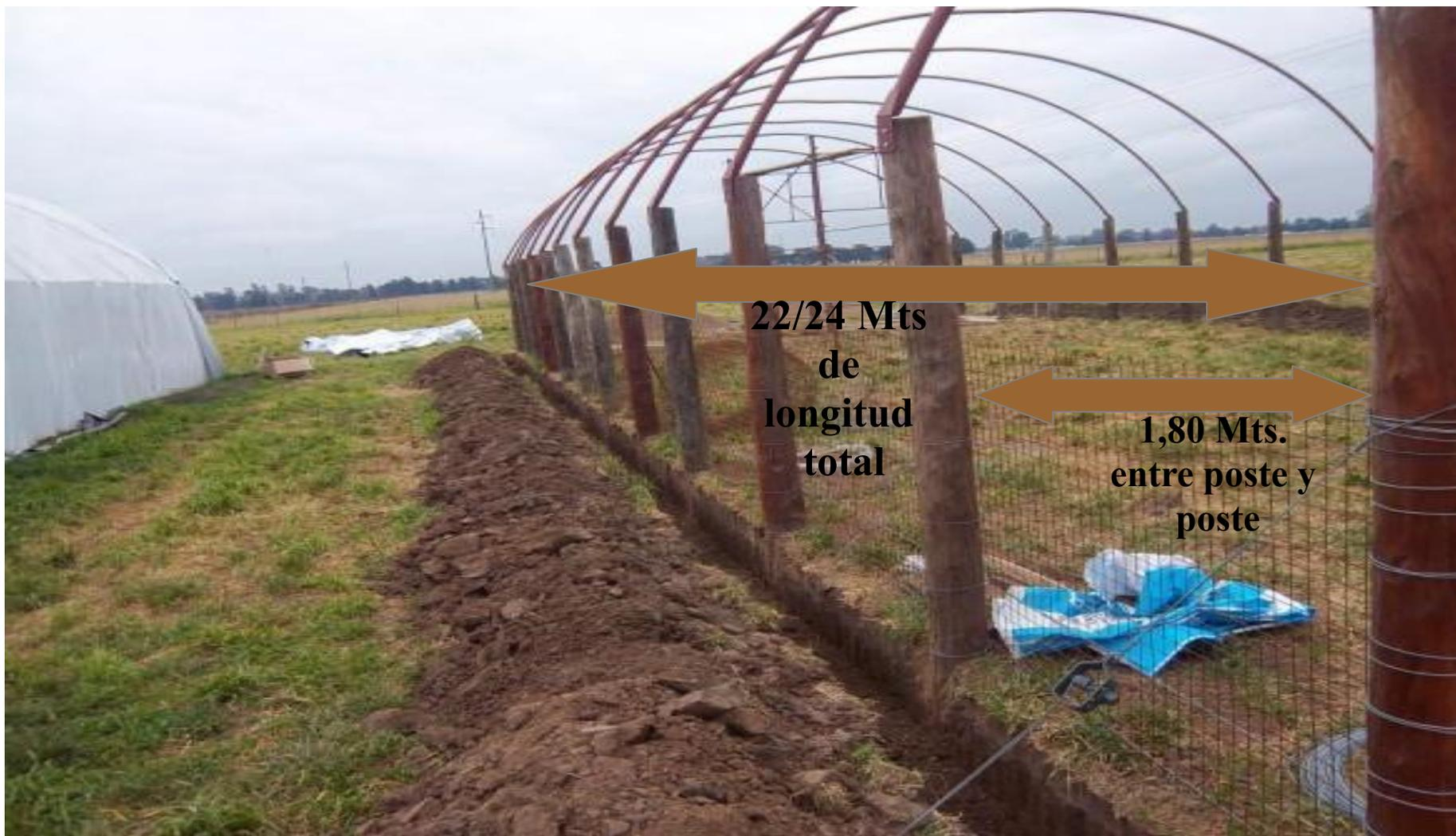
La distancia entre los arcos es variable entre 1.8 a 2.0 m. Completa la estructura, caños transversales, a 2 mts de altura, de una pulgada de diámetro que mantiene la rigidez en los arcos principales superiores.
