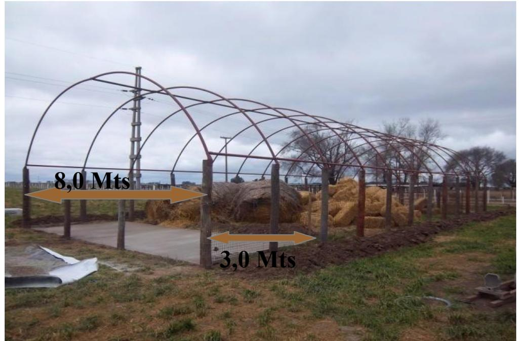
La estructura es cubierta con material de los silos bolsa .
